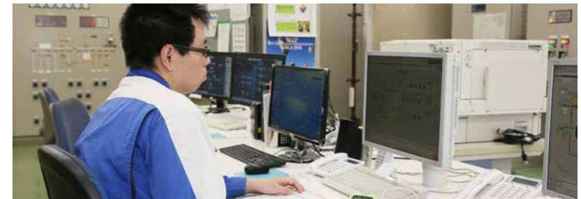
〈左頁〉施設の全景。写真左奥に有明海が広がる 〈上〉中央監視室では職員が水質を24時間体制で監視する
