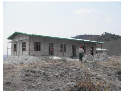
サウンウン小学校建設
