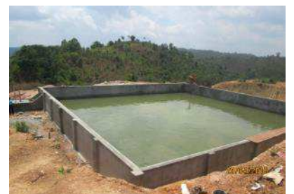
給水用の水タンク建設
