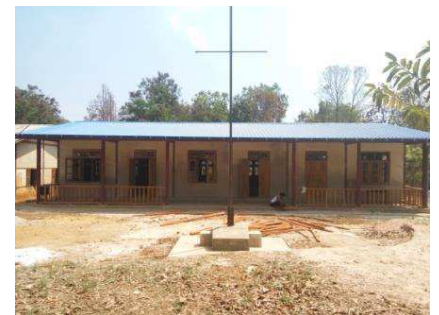
完成したカウントー小学校
