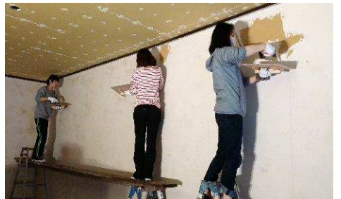
空き家の改装はボランティアさんの手で (空き家対策事業)
