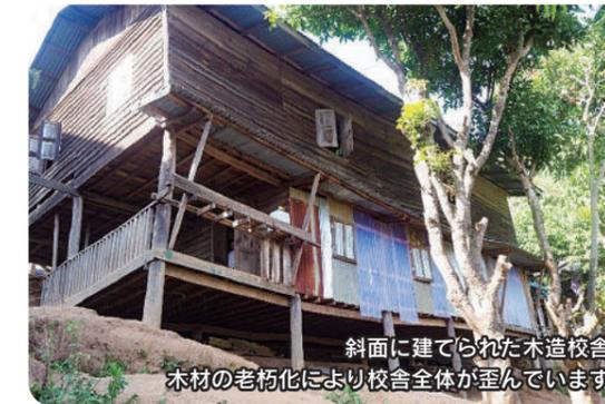
斜面に建てられた木造校舎木材の老朽化により校舎全体が歪んでいます
