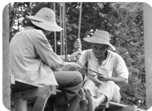
作業に励む建設スタッフ
