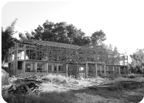
建設中のナウンカセンター
